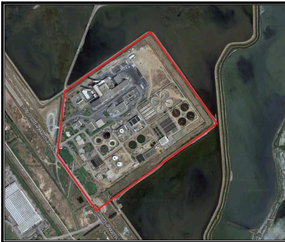
Figura 2: Vista aerea dello stabilimento del "TECNOCASIC" Strada Dorsale Consortile km. 10,500, 09134 Localita' Macchiareddu, Capoterra
