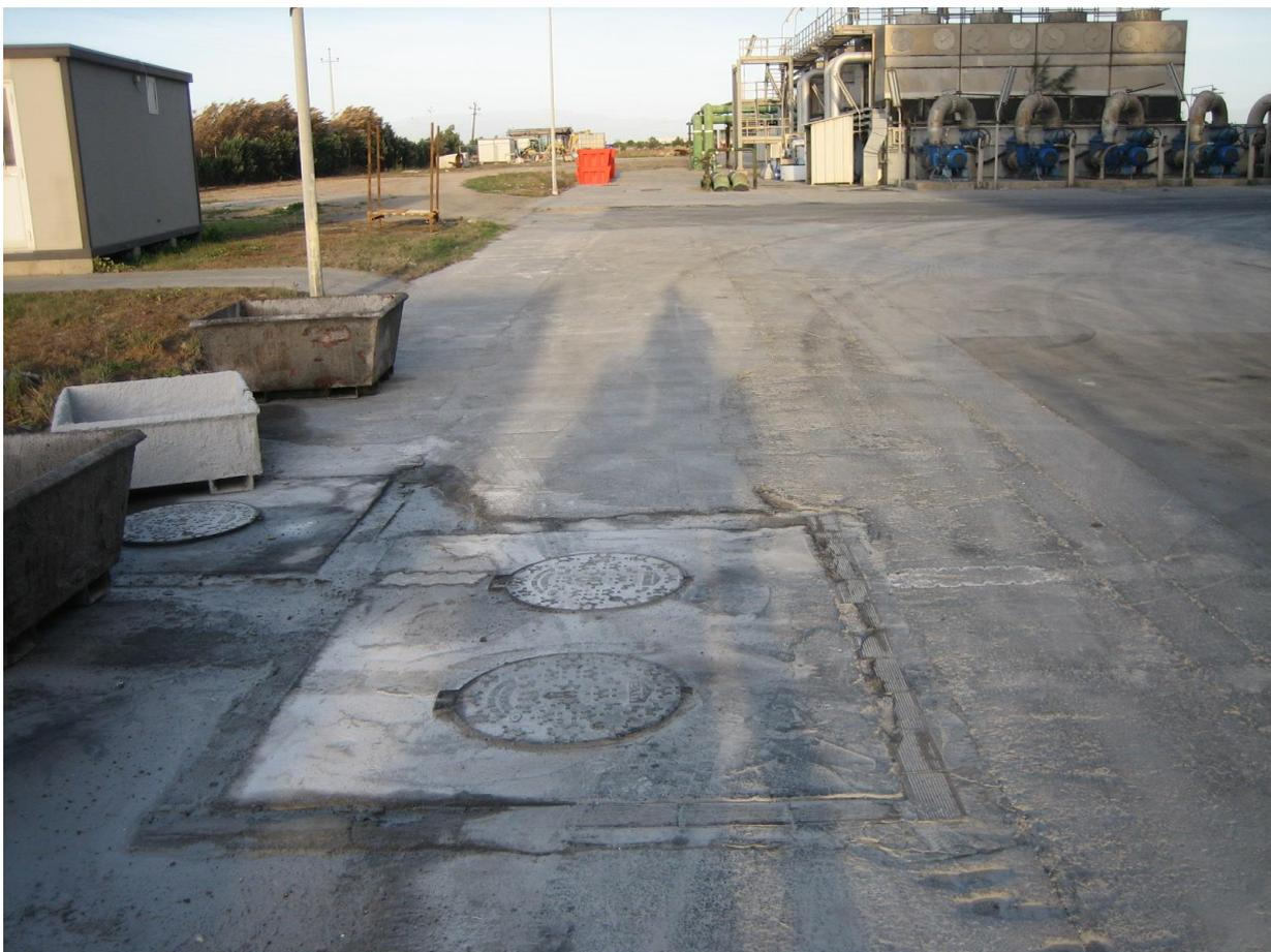
*Figura 11: Strada perimetrale di stabilimento con camera interrata dei cavidotti interrati*
