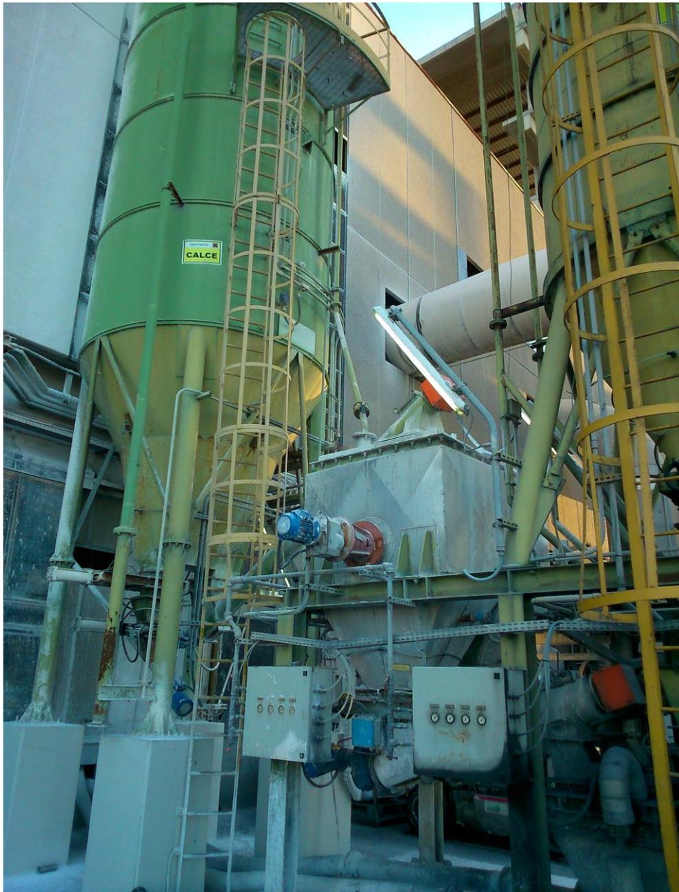
*Figura 7: Impianto di preparazione del latte di calce*
