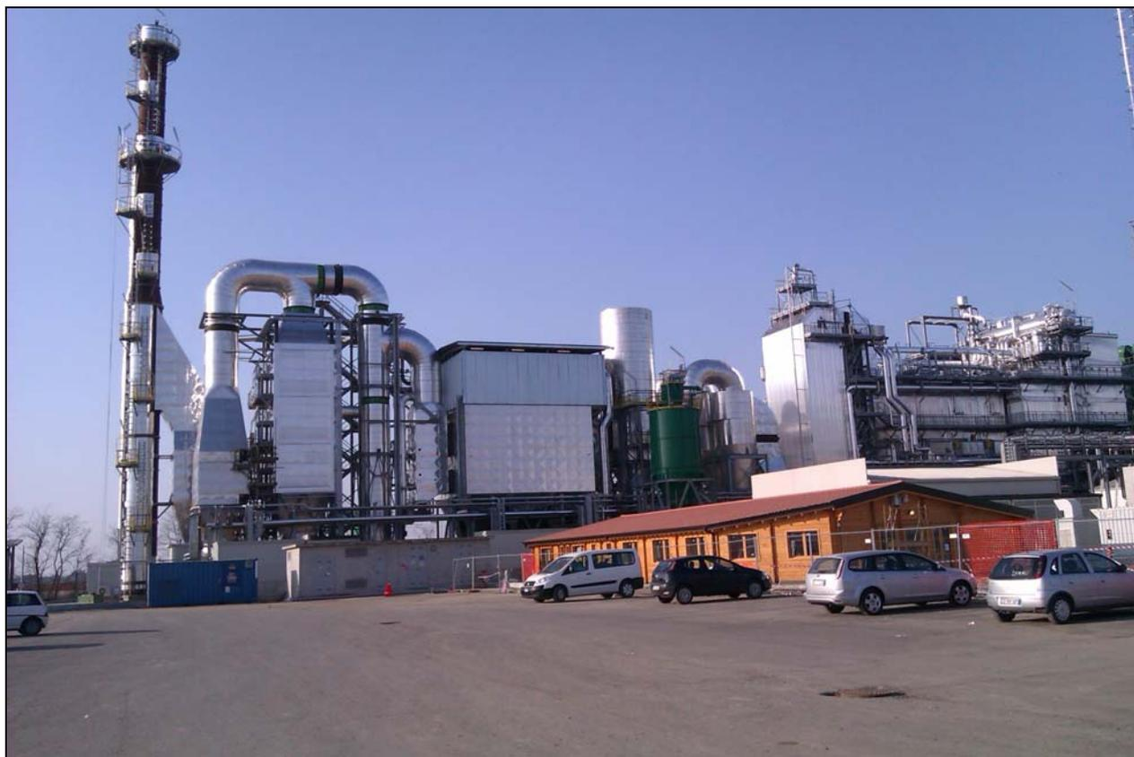
**Figura 1: Linea trattamento fumi con Cicloni , Reattore , Filtro a Maniche SCR ,Scambiatore e Ventilatore esaustore.**
