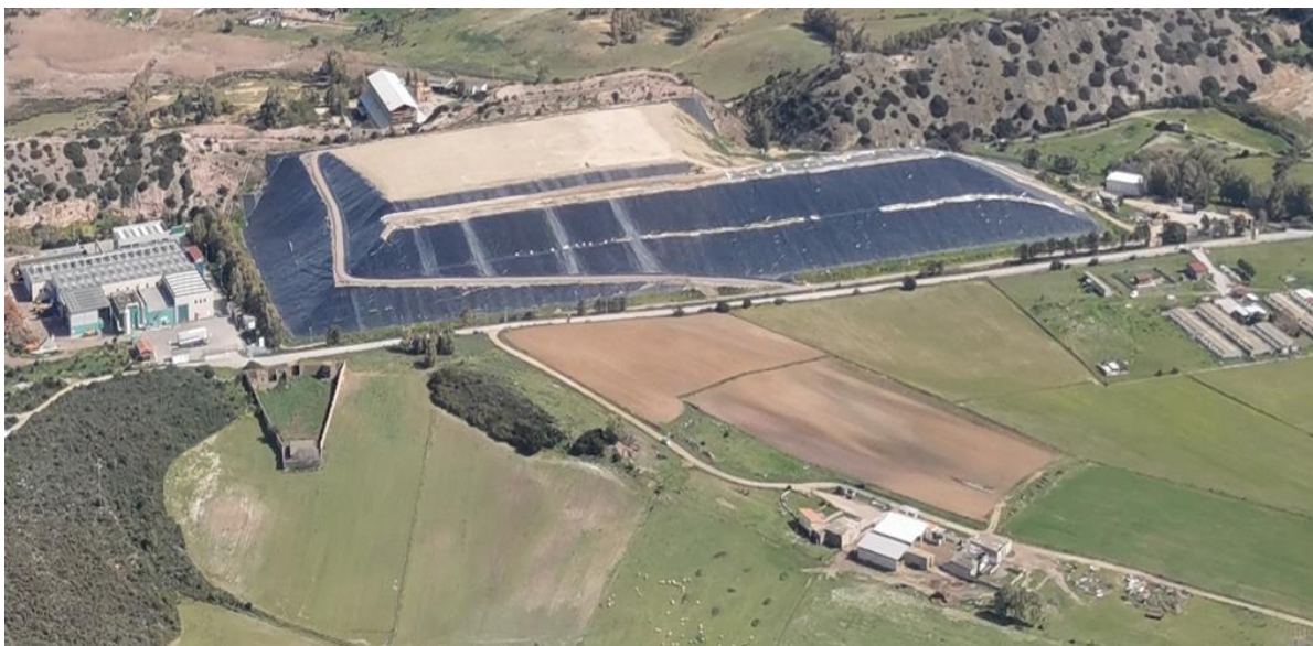
Tavola 4: Vista aerea al termine dei lavori del lotto I
