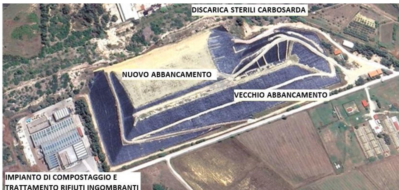
Tavola 3: Ortofoto della discarica con la sua suddivisione in blocchi: vecchio e nuovo abbancamento
